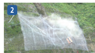
重錘を金網と地山の間に網裾まで誘導
