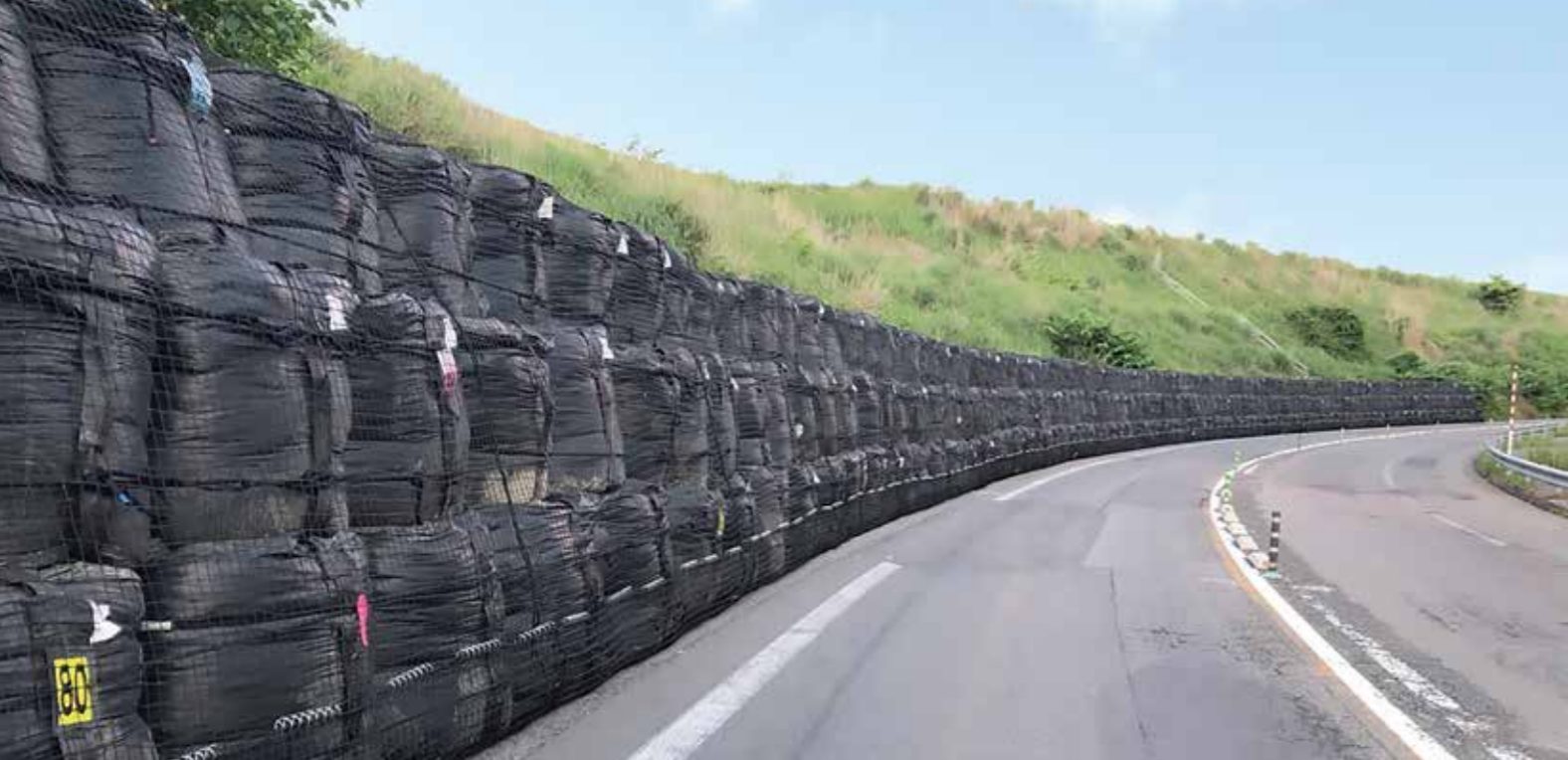
落石・崩壊土砂防護大型土のう擁壁
