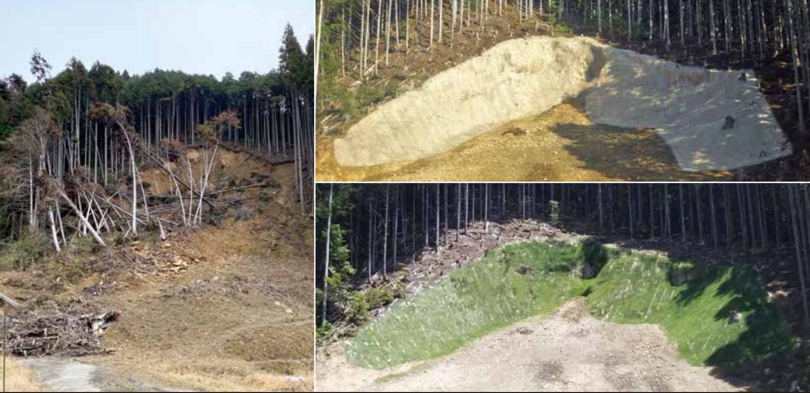
斜面侵食防止 表層土砂流出抑制対策工法
