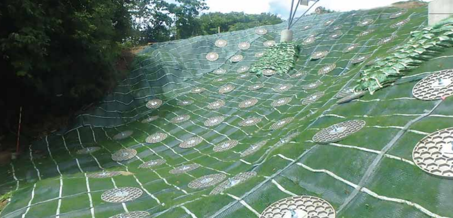
鉄筋挿入工用アルミ製反力体
