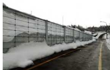
■ 施工事例 (せり出し防止柵)
