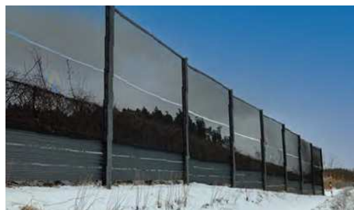
■ 縦断勾配に対応した施工事例
