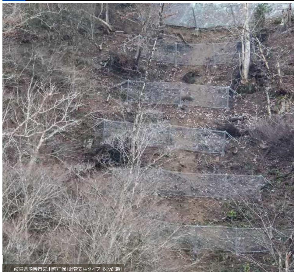
岐阜県飛騨市宮川町打保（鋼管支柱タイプ 多段配置）
