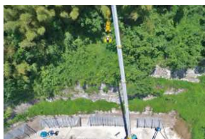
■ 実験状況 (重錐落下前)
