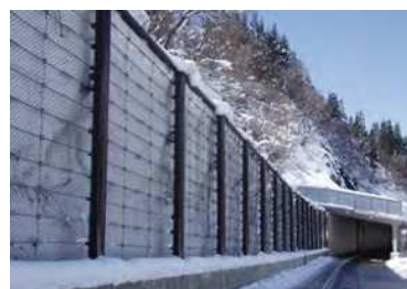
■ 施工事例 (崩落雪防止柵)
