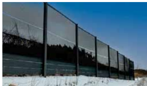
■ 縦断勾配に対応した施工事例
