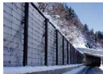
■ 施工事例 (崩落雪防止柵)
