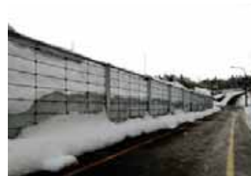
■ 施工事例 (せり出し防止柵)
