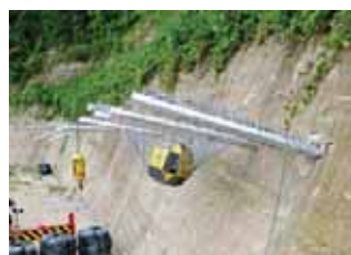
■ 1000kJタイプ重錘捕捉状況
