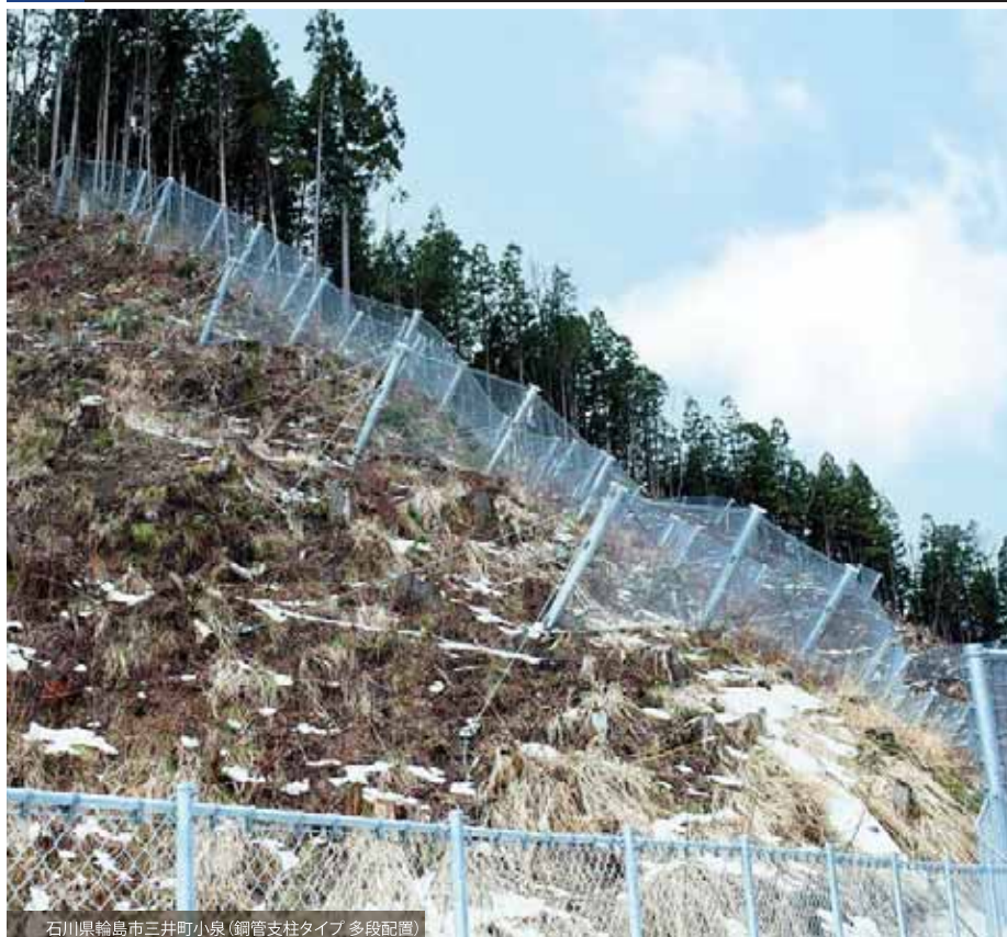
石川県輪島市三井町小泉（鋼管支柱タイプ 多段配置）
