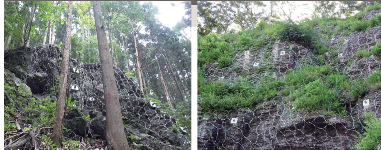
落石発生源対策・表層崩壊（土砂・岩盤）対策
