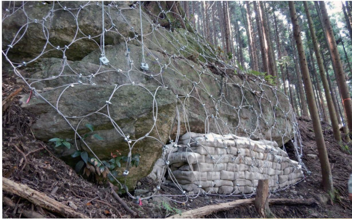
根固マットにより地盤支持力を増強する仕組み
