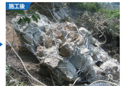
概要 落石防護網に落下した転石の安定化
