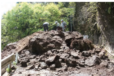
■ 崩落岩盤撤去工事
