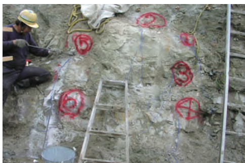
■ 岩盤掘削・撤去工事【破砕前】
