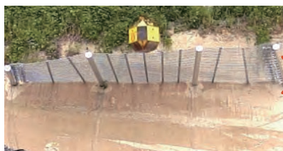
■ 5.2t重錘衝突状況
