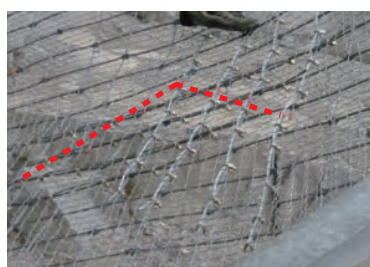
■ ケーブルネット補修 (破断部切断箇所)
