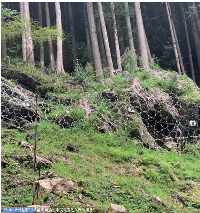
ワイヤーネット被覆工法 静岡県浜松市天竜区佐久間町相月
