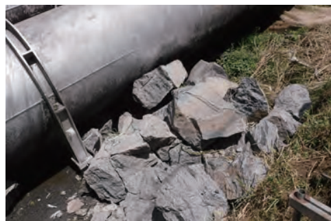
■ 落石撤去工事
