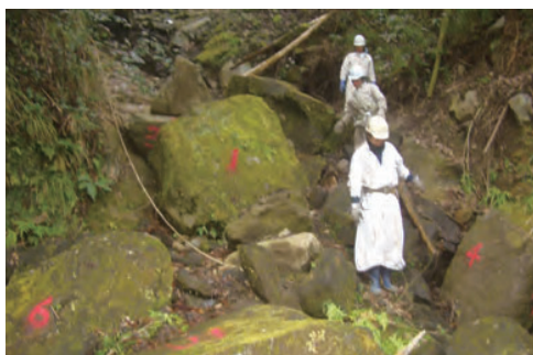
■ 落石岩盤撤去工事【破砕前】
