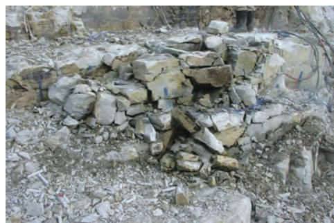
■ 岩盤掘削・撤去工事【破砕後】
