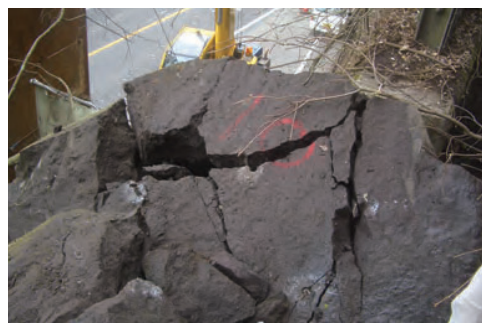
■ 落石岩盤撤去工事【破砕後】
