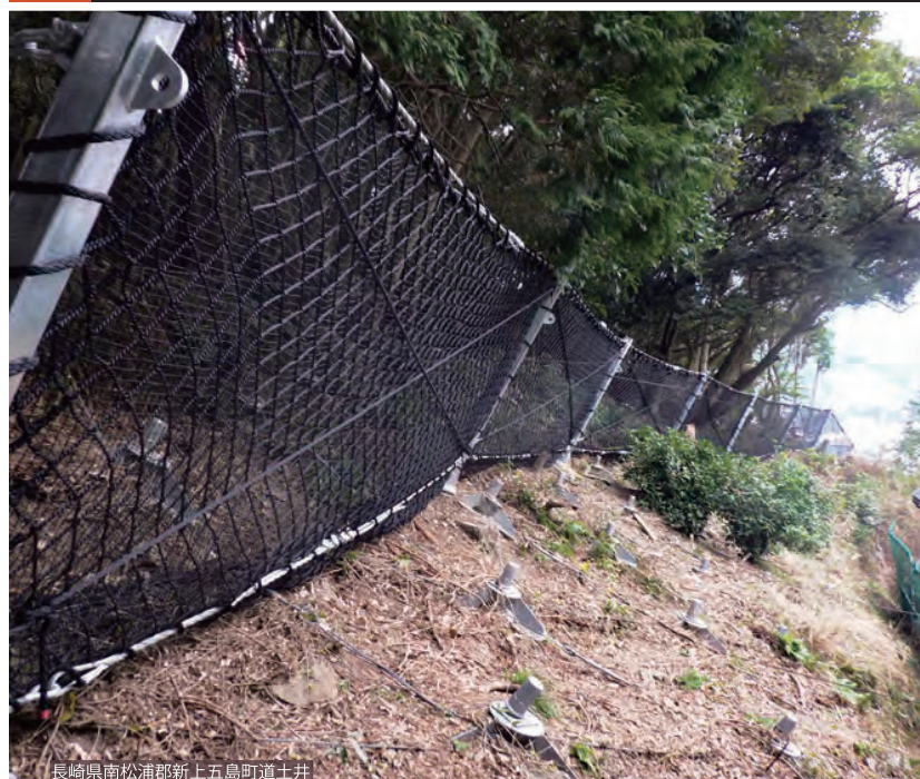
長崎県南松浦郡新上五島町道土井
