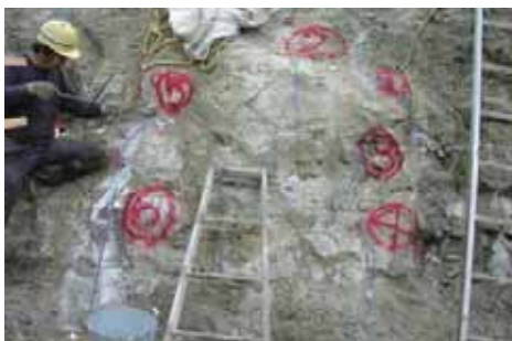
■ 岩盤掘削・撤去工事【破碎前】
