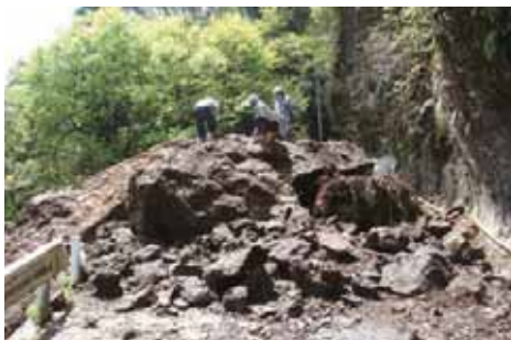
■ 崩落岩盤撤去工事
