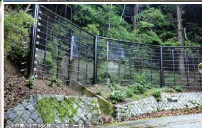
兵庫県神戸市中央区神戸港地方口一里山
