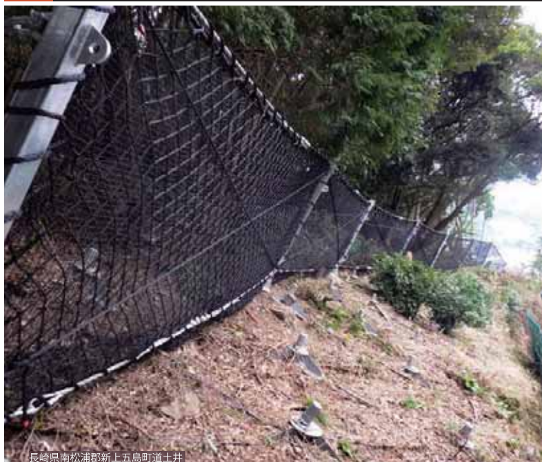
長崎県南松浦郡新上五島町道土井
