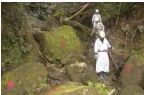
■ 落石岩盤撤去工事【破碎前】
