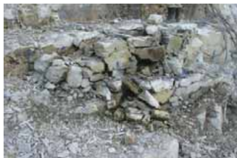
■ 岩盤掘削・撤去工事【破碎後】
