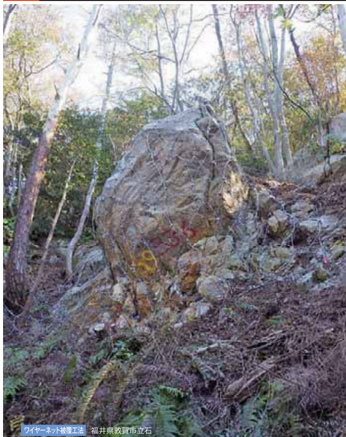
ワイヤーネット被覆工法 福井県敦賀市立石
