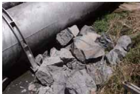
■ 落石撤去工事
