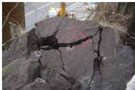
■ 落石岩盤撤去工事【破碎後】
