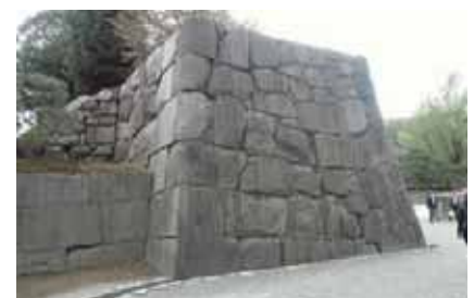
■ 高耐久STKネット 施工事例
