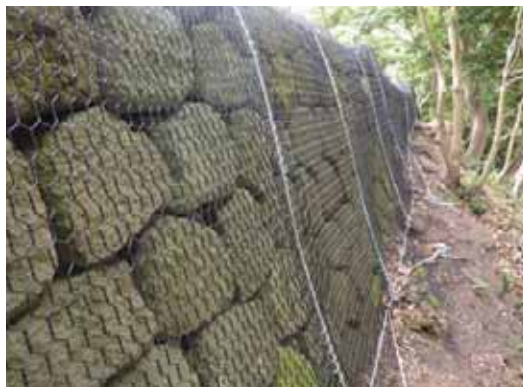
■ 石垣等の補強工
