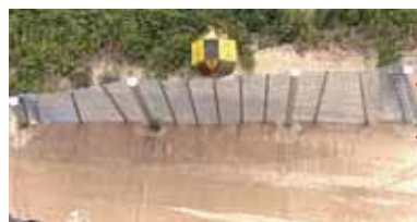
■ 5.2t重錘衝突状況
