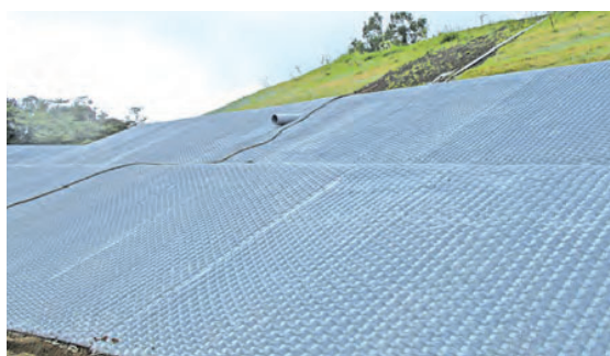
■ 法面保護工(調整池)
