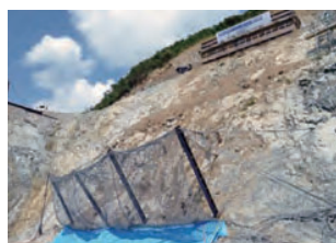
■ 実験状況 (土砂流下前)
