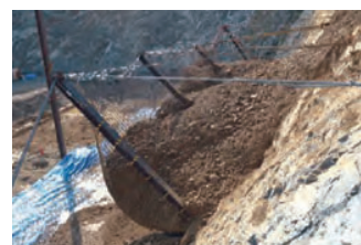
■ 実験状況 (土砂捕捉後)
