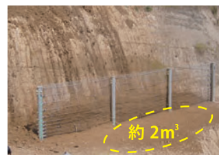
■ 捕捉状況 (改良金網使用時) 【金網3.2φ×25×25mm】
