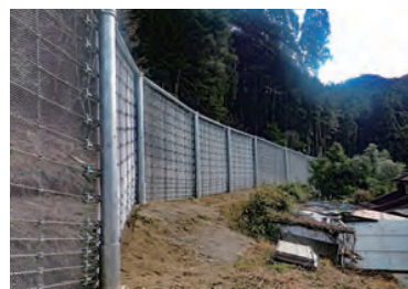
■ 施工事例 (崩壊土砂防護柵)
