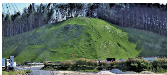
■ 山口県光市小周防【施工後(4ヶ月)】
