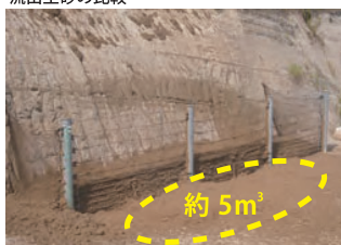
■ 捕捉状況 (標準金網使用時) 【金網4.0φ×50×50mm】
