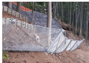
■ 施工事例 (崩壊土砂防護柵)
