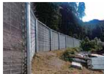
■ 施工事例 (崩壊土砂防護柵)
