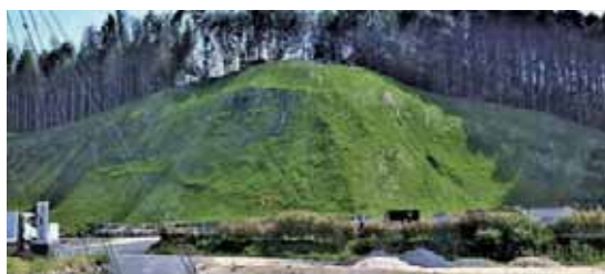
■ 山口県光市小周防【施工後(4ヶ月)】
