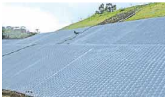
■ 法面保護工（調整池）
