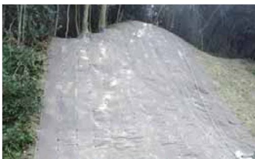
■ 法面保護対策
