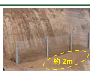
■ 捕捉状況 (改良金網使用時) 【金網3.2φ×25×25mm】
