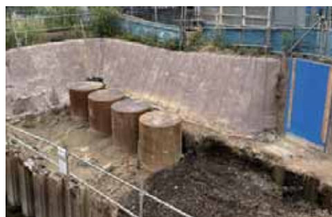
■ 土砂流出対策
