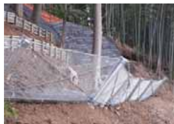
■ 施工事例 (崩壊土砂防護柵)
