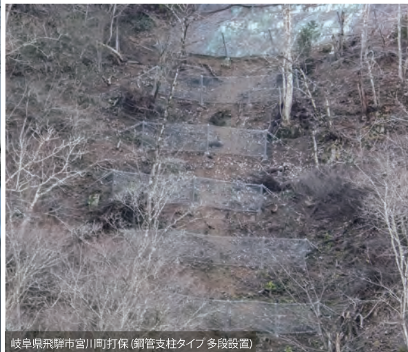
岐阜県飛騨市宮川町打保（鋼管支柱タイプ 多段設置）
