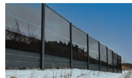
■ 縦断勾配に対応した施工事例
