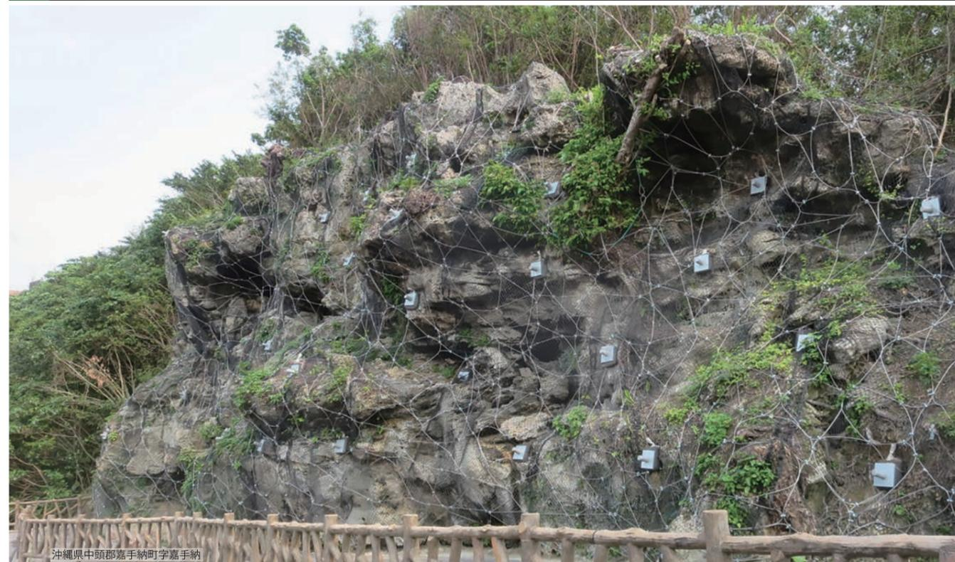
**製品概要** 土砂および岩盤を対象にした斜面崩壊対策工法
