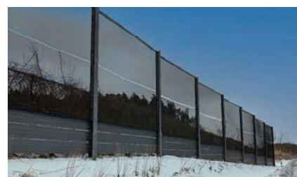
■ 縦断勾配に対応した施工事例
