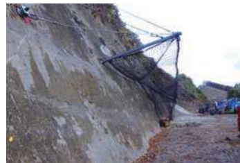
■ 実規模実証実験 重錘捕捉状況(新素材ネット)
