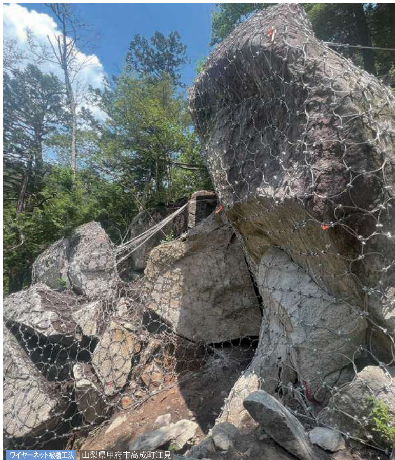
ワイヤーネット被覆工法 山梨県甲府市高成町江見
