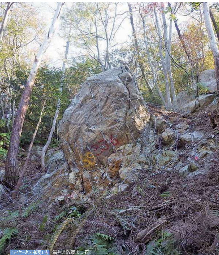
ワイヤーネット被覆工法 福井県敦賀市立石
