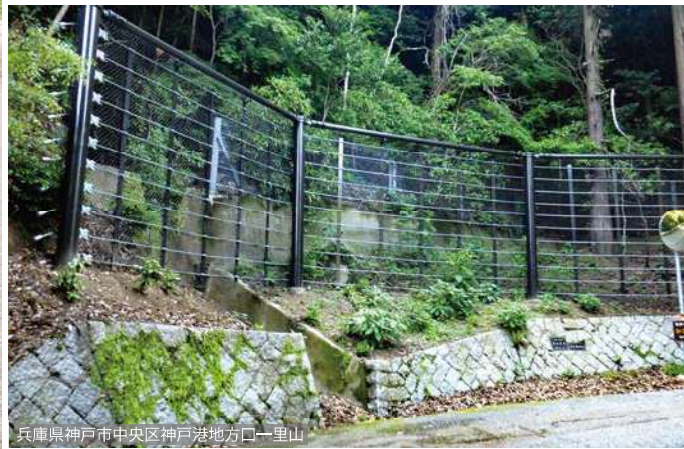
兵庫県神戸市中央区神戸港地方一里山
