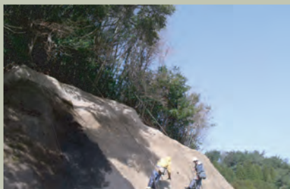
③下地処理工（洗浄・目粗し）
