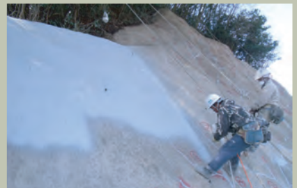
⑦靱性モルタルライニング
