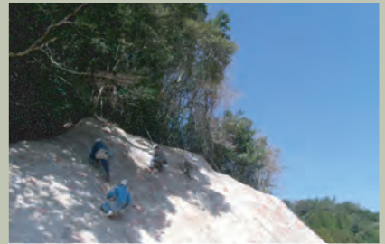
⑤ひび割れカット・充填工
