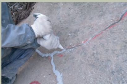
⑤ひび割れ充填工
