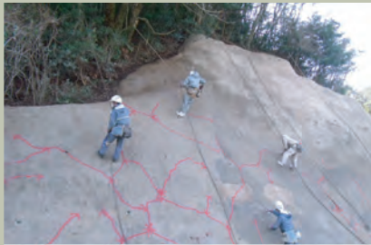
④ひび割れマーキング・測定工
