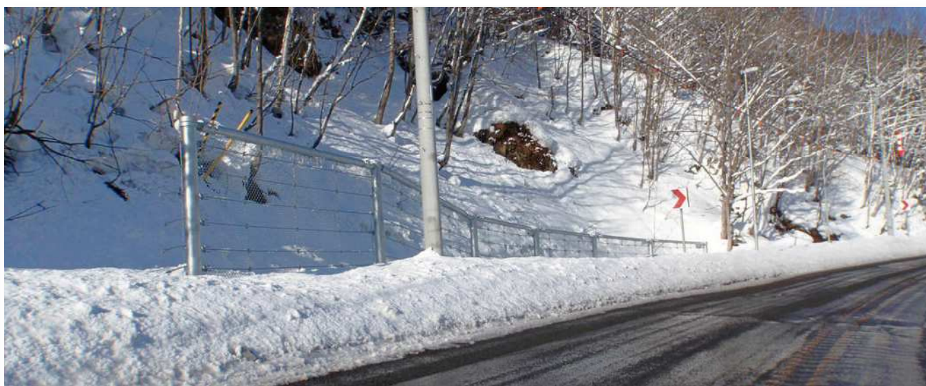
北海道 上川郡上川町層雲峡洗堀 (国土交通省 北海道開発局 旭川開発建設部)
