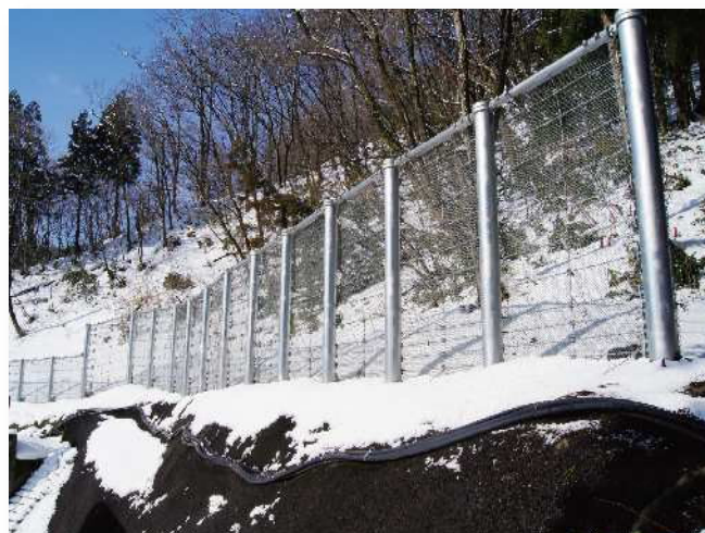
富山県 南砺市小二又 (富山県 砺波土木センター)
