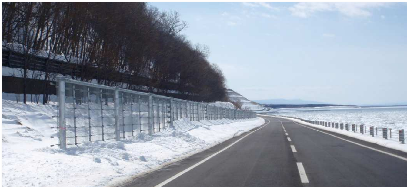
北海道 斜里郡斜里町 (国土交通省 北海道開発局 網走開発建設部)
