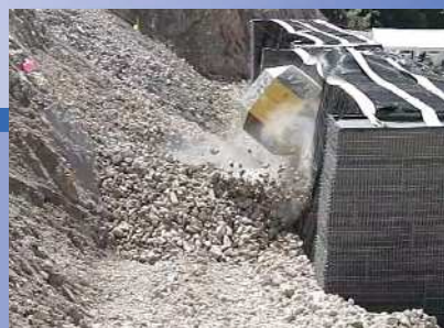
●実斜面を用いた実規模実証実験の状況
