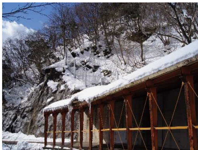
富山県 南砺市利賀村栗当 (富山県 砺波土木センター)
