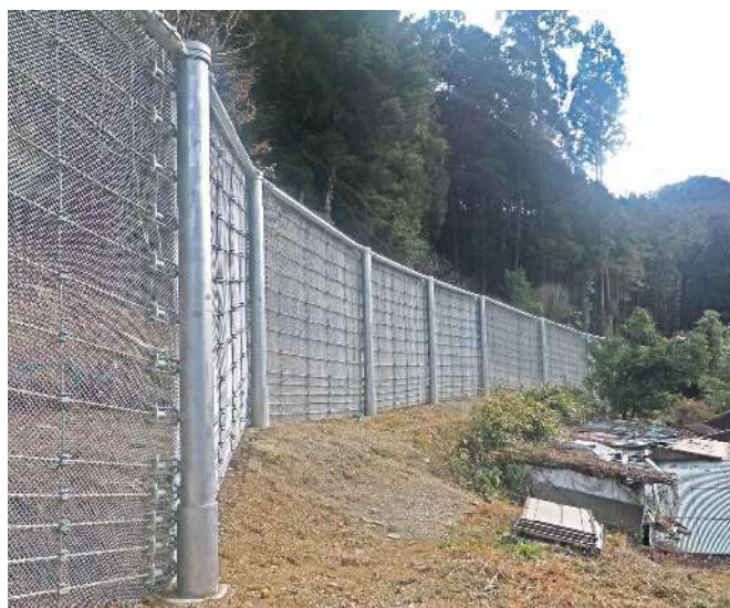
埼玉県ときがわ町大野 支柱ジョイント HEF
