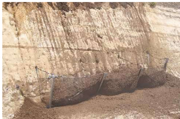
土砂捕捉状況
