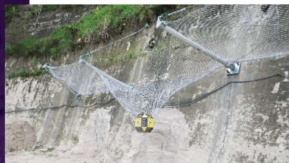
鉛直落下式による実規模実証実験
