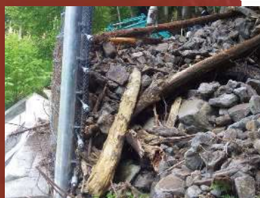
被災事例（崩土・流木）
