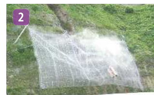
2 重錘を金網と地山の間に網裾まで誘導
