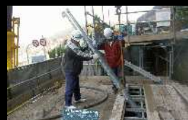
中間鋼管建て込み
