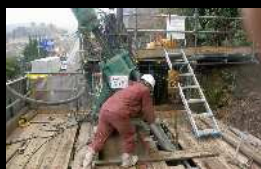
外側鋼管建て込み
