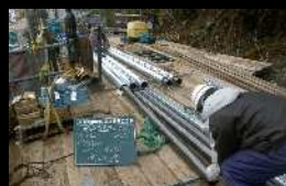
内側鋼管挿入
