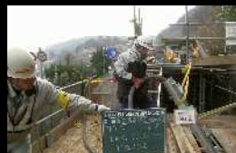
内側モルタル充填
