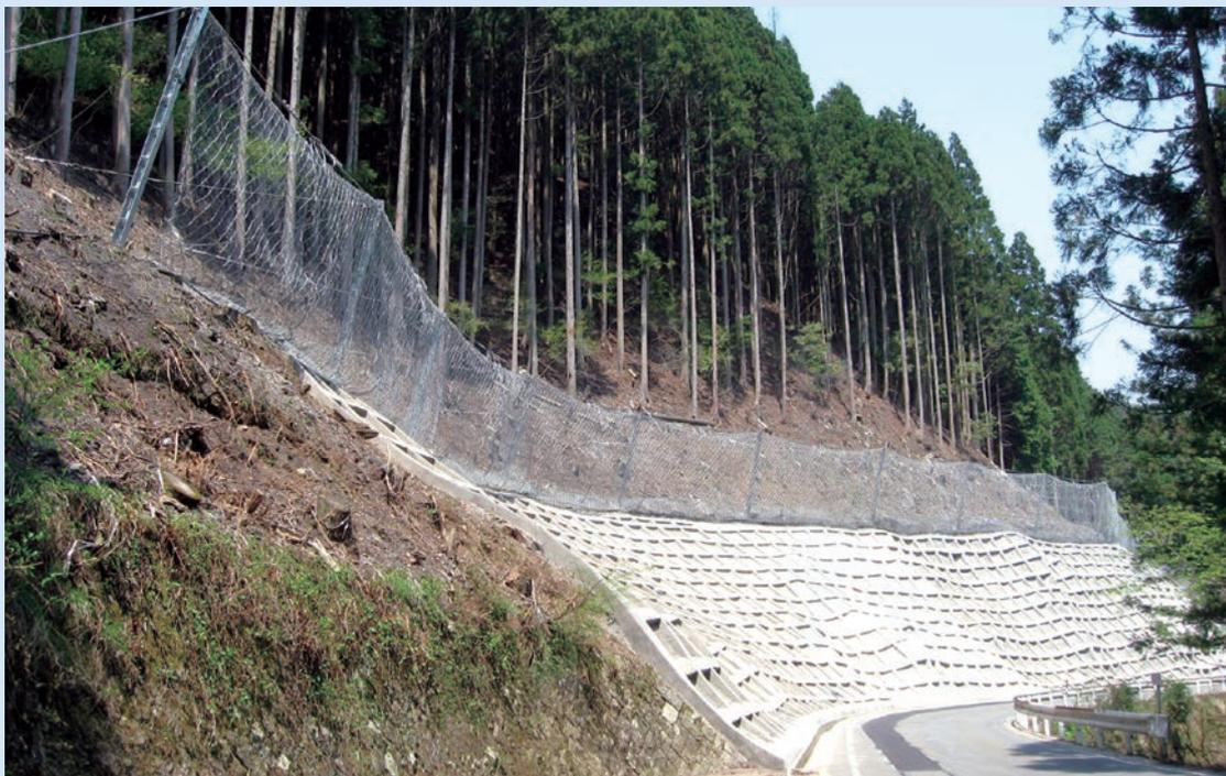
高エネルギー吸収型 落石防止柵
