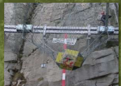
●実物実験（落石捕捉状況）
