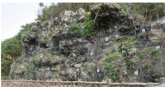
ステンレス製ワイヤーリングを用いた斜面崩壊（土砂・岩盤）対策
