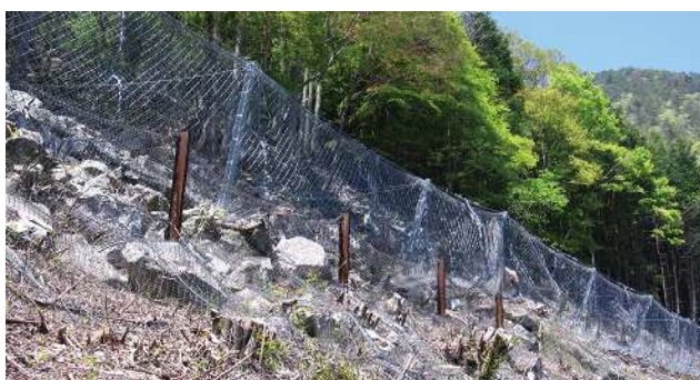
高エネルギー吸収柵 (落石防護・土砂防護・積雪対応)
