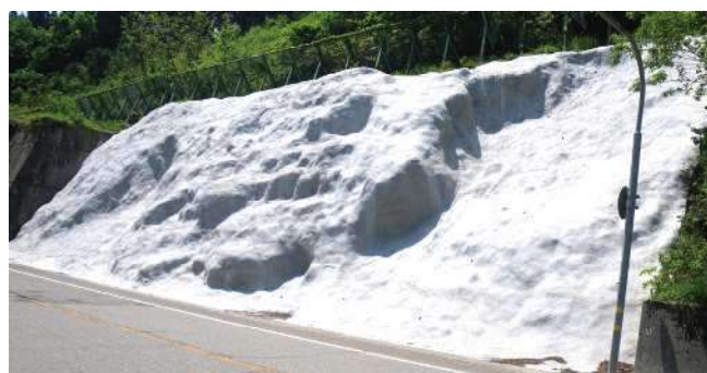
法面靱性モルタル表面保護工法
