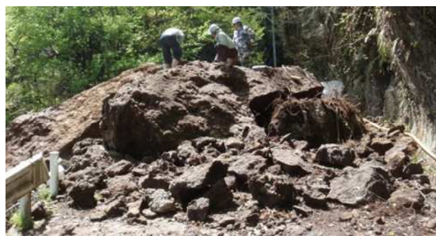
岩盤・コンクリート破碎工法
