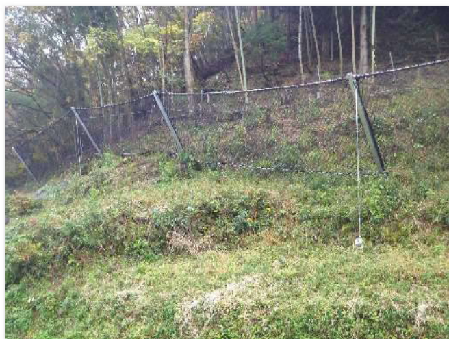
兵庫県養父市奥米地（兵庫県養父土木事務所）
