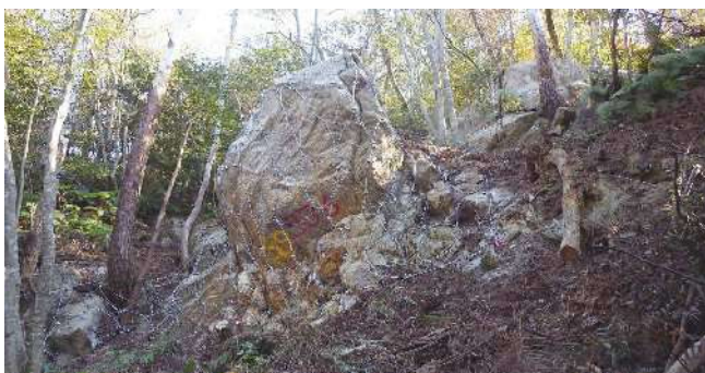
ステンレス製ワイヤーリングを用いた落石発生源対策
