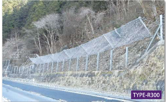
宮城県登米市津山町柳津 ( 東北地方整備局仙台河川国道事務所 )
