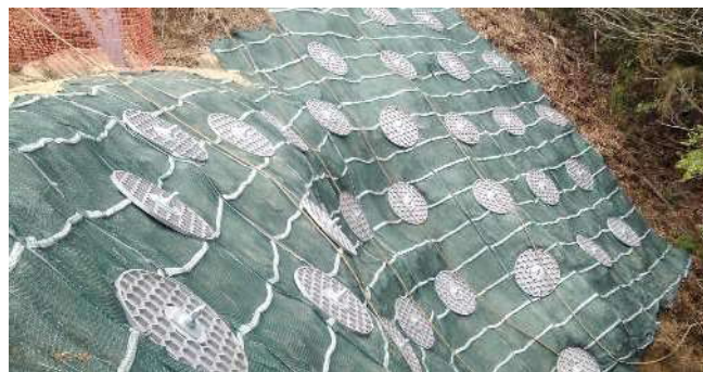
鉄筋挿入工用アルミ製反力体
