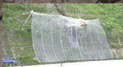
●斜面滑走式による実規模実証実験（令和2年）
