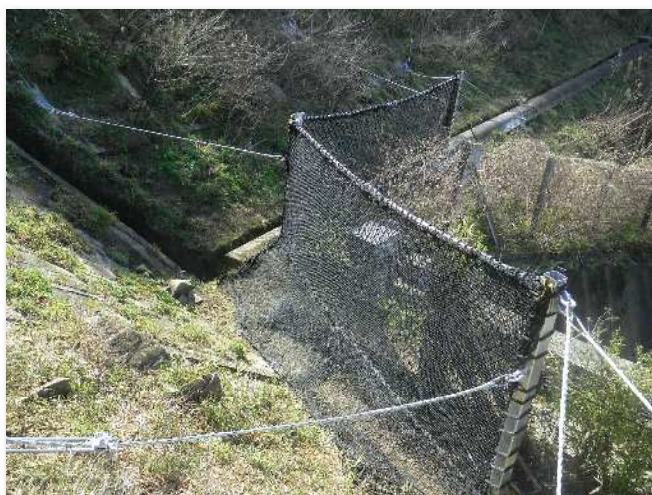
福岡県北九州市八幡東区帆柱地内（福岡北九州高速道路公社）
