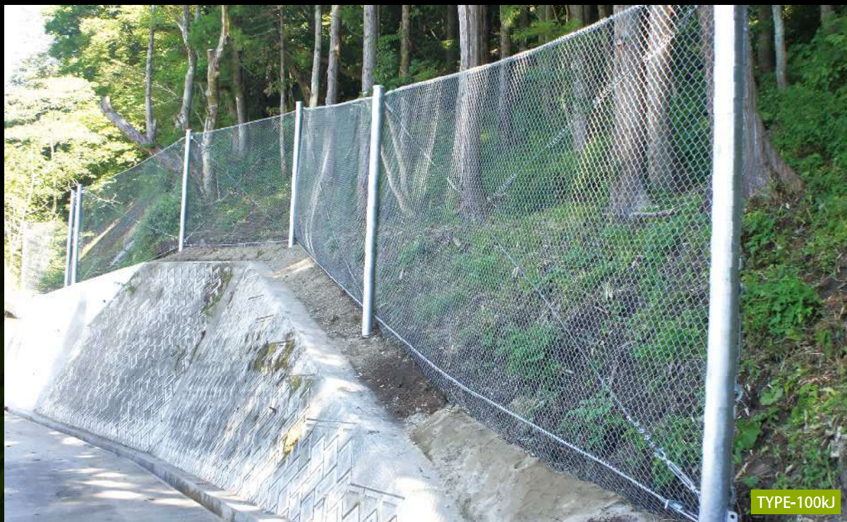
福島県大沼郡三島町大字松原地内（福島県宮下土木事務所）
