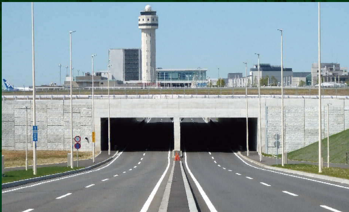
北海道新千歳空港誘導路（北海道開発局札幌開発建設部）
