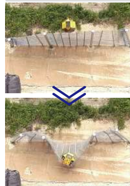
【HRF工法】重錘質量：5.2t
