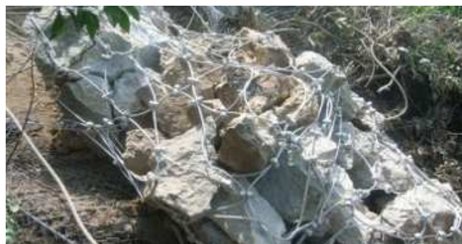
ステンレス製ワイヤーリングを用いた小割（残置・除去）対策
