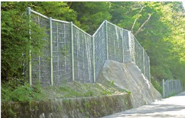
福井県南条郡南越前町板取 (福井県丹南土木事務所)
