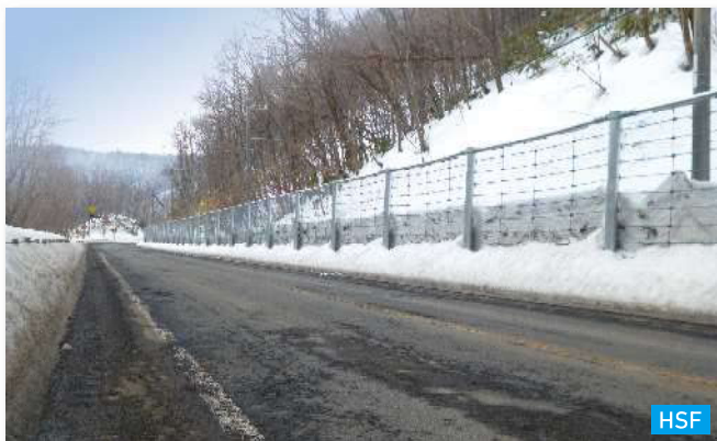
北海道石狩市送毛（北海道開発局札幌開発建設部滝川道路事務所）
