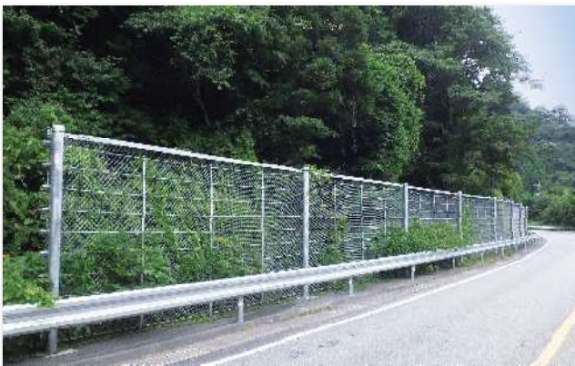
山口県長門市三隅上地内 (中国地方整備局山口河川国道事務所)
