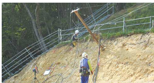
無足場削孔工
