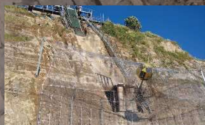
●斜面転落式による実規模実証実験（平成24年）
