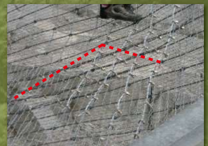
●ケーブルネット補修（破線部切断箇所）
