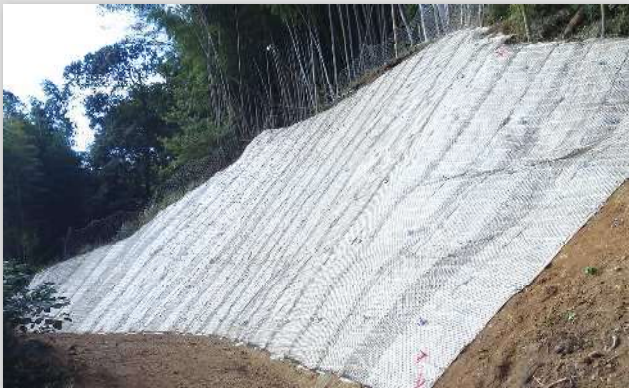
施工完了直後
