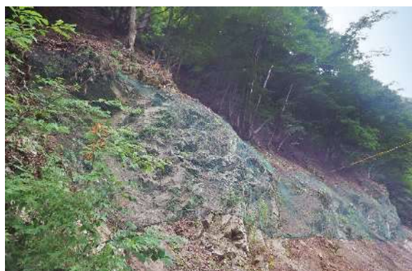
長野県大鹿村桶谷（中部地方整備局天竜川ダム統合管理事務所）
