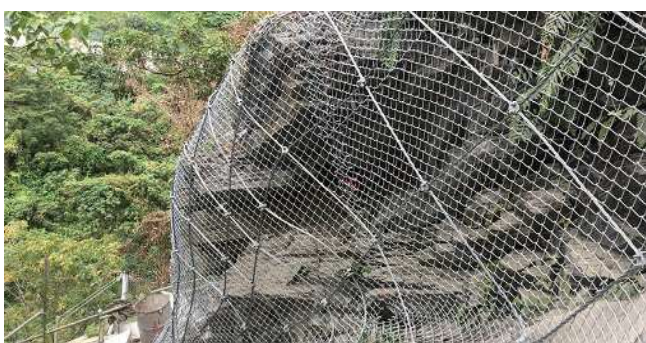
ワイヤロープ伏工
