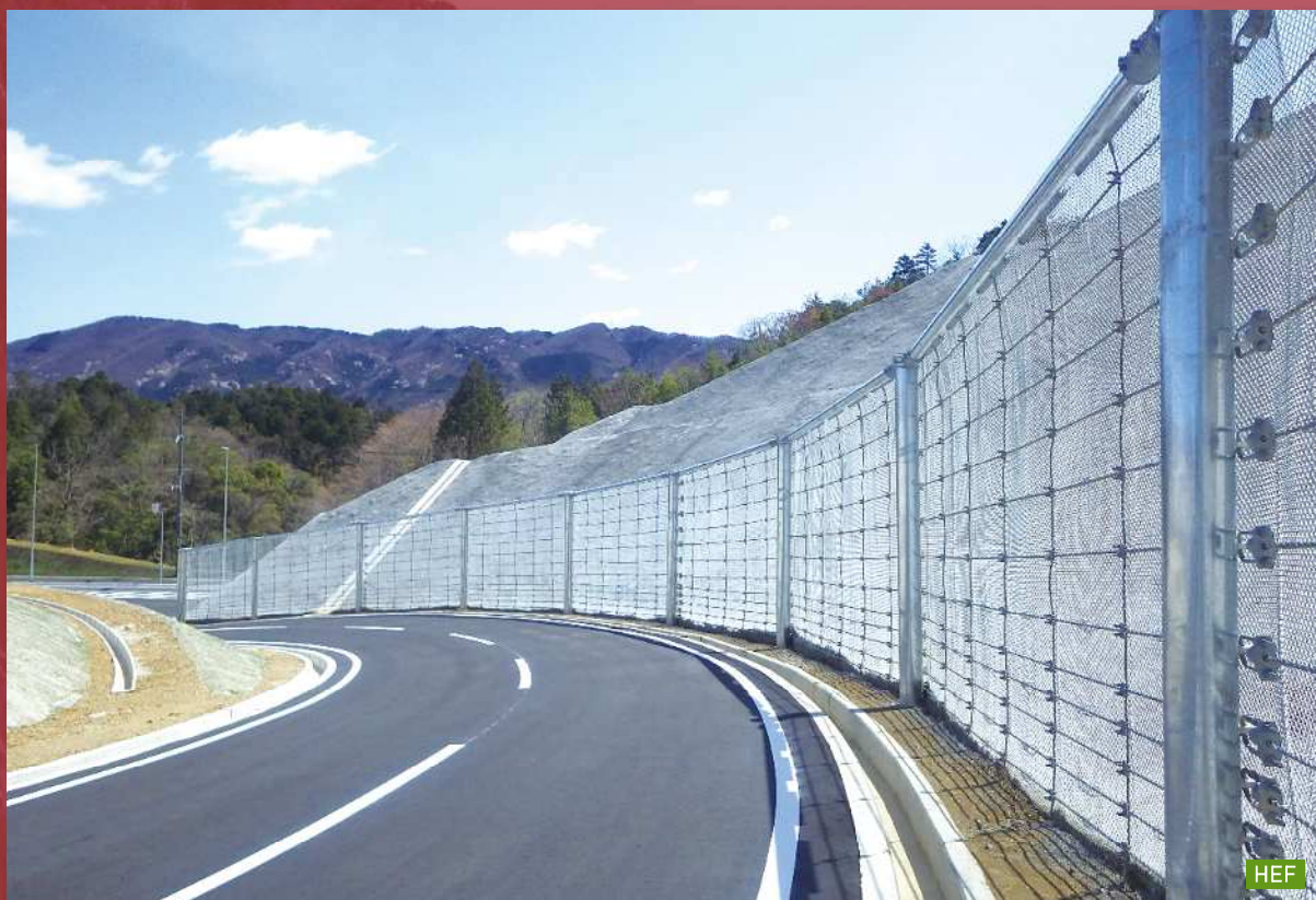
大阪府箕面市下止々呂美地内 ( 大阪府都市整備部箕面整備事務所 )
