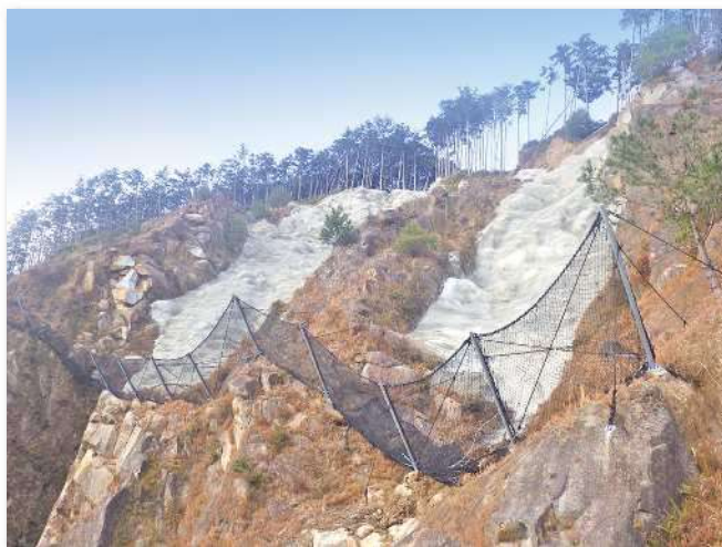
三重県尾鷲市南浦地内（中部地方整備局紀勢国道事務所）
