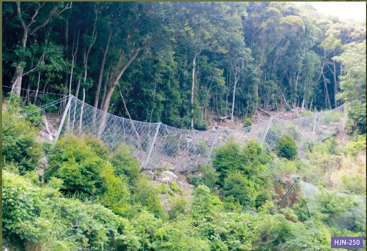
三重県熊野市佐田坂地内（中部地方整備局紀勢国道事務所）
