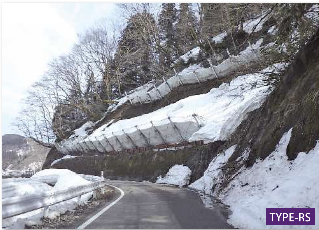
富山県富山市八尾町若ヶ島地内 ( 富山県富山土木センター )
