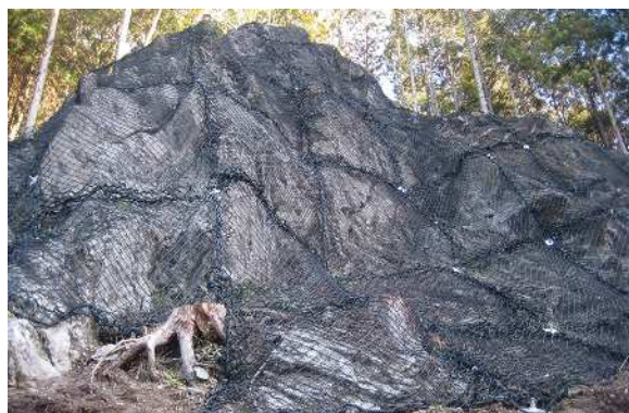
静岡県浜松市佐久間町浦川（中部地方整備局浜松河川国道事務所）
