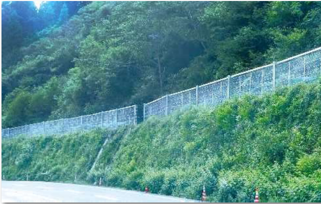
岐阜県関市中之保 (岐阜県美濃土木事務所)
