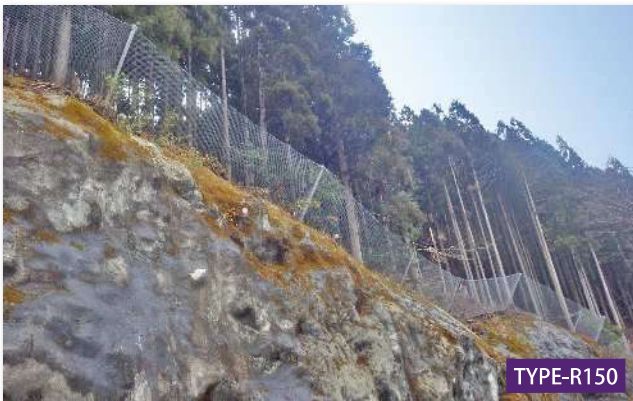
京都府京丹波町細谷地内 ( 京都府南丹土木事務所 )
