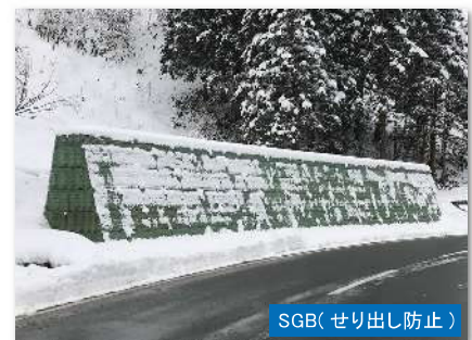
山形県最上郡大蔵村大字南山地内 (山形県最上総合支庁建設部)
