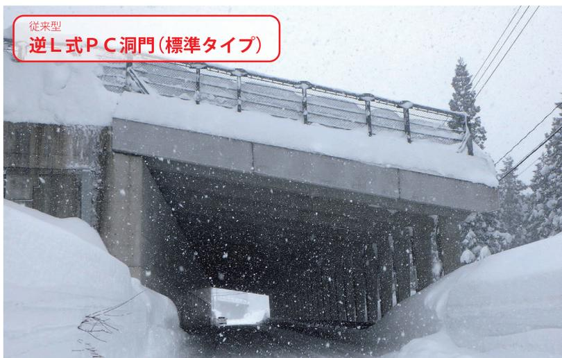
プレストレストコンクリート製の主梁と柱を剛結した逆L2ヒンジ構造
