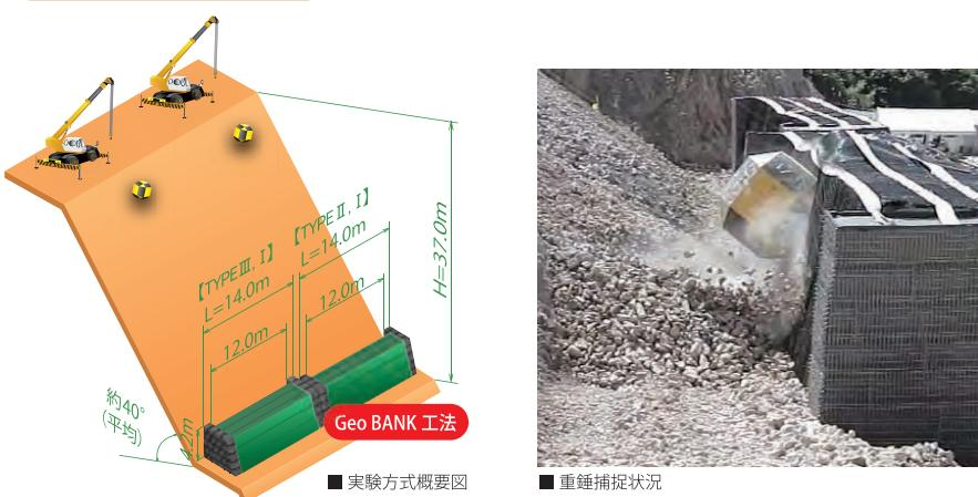
EGB工法は、落石兼用も可能であり、落石については、国立大学法人金沢大学との共同研究で、実斜面を用いた「斜面転落式」実験により、落石に対する防護性能を検証しています。
