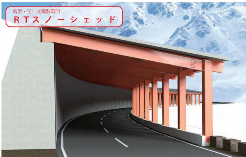
鋼製の主桁と柱を剛結した逆L構造であり、構造の大型化、簡素化を図った新型スノーシェット
